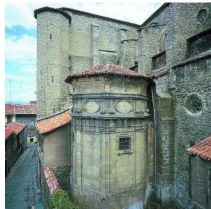
Capilla. Imagen del exterior antes de su restauración.
